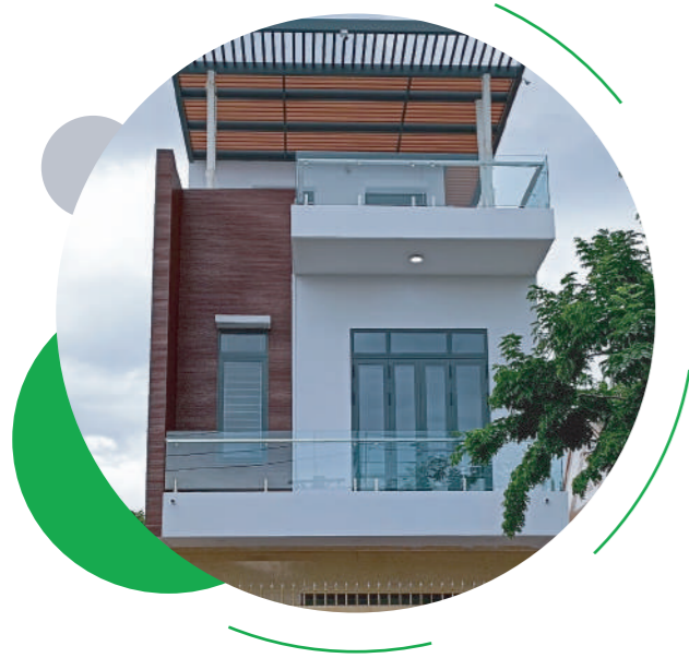
Công trình nhà phố Phước Long, Phước Bình
